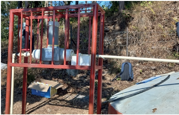
চিত্র ৬: পিওর অল ১০০ নামক যন্ত্র কর্নালি প্রদেশে পাইপ সরবরাহের জন্য ইন-লাইন ক্লোরিনেশন প্রদান করছে।
