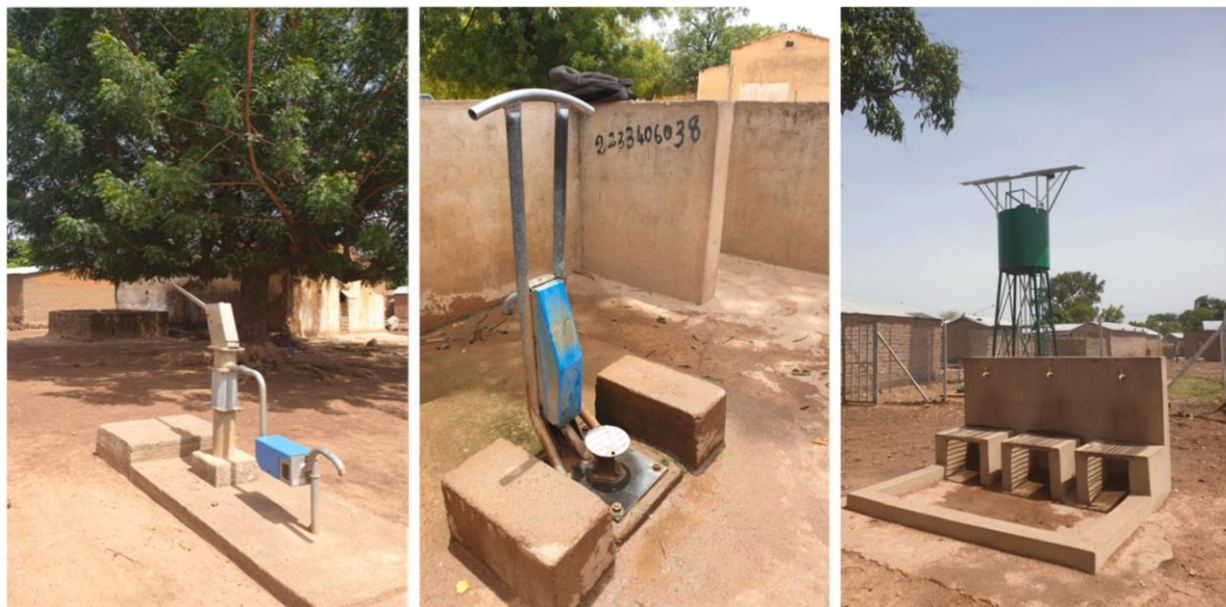
Fig. 1. Types d'infrastructure gérés par UDUMA : pompe à pied, pompe à main, kiosque solaire.
